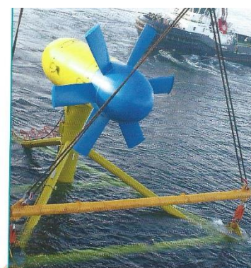
4 Installation d'une hydrolienne au large de la Bretagne. Cette hydrolienne est immergée à 50 m de profondeur. Elle permet de convertir l'énergie fournie par les courants marins de surface en énergie électrique.
