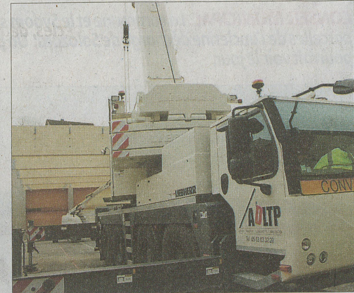
Des moyens hors norme pour installer la charpente. \E.L.
