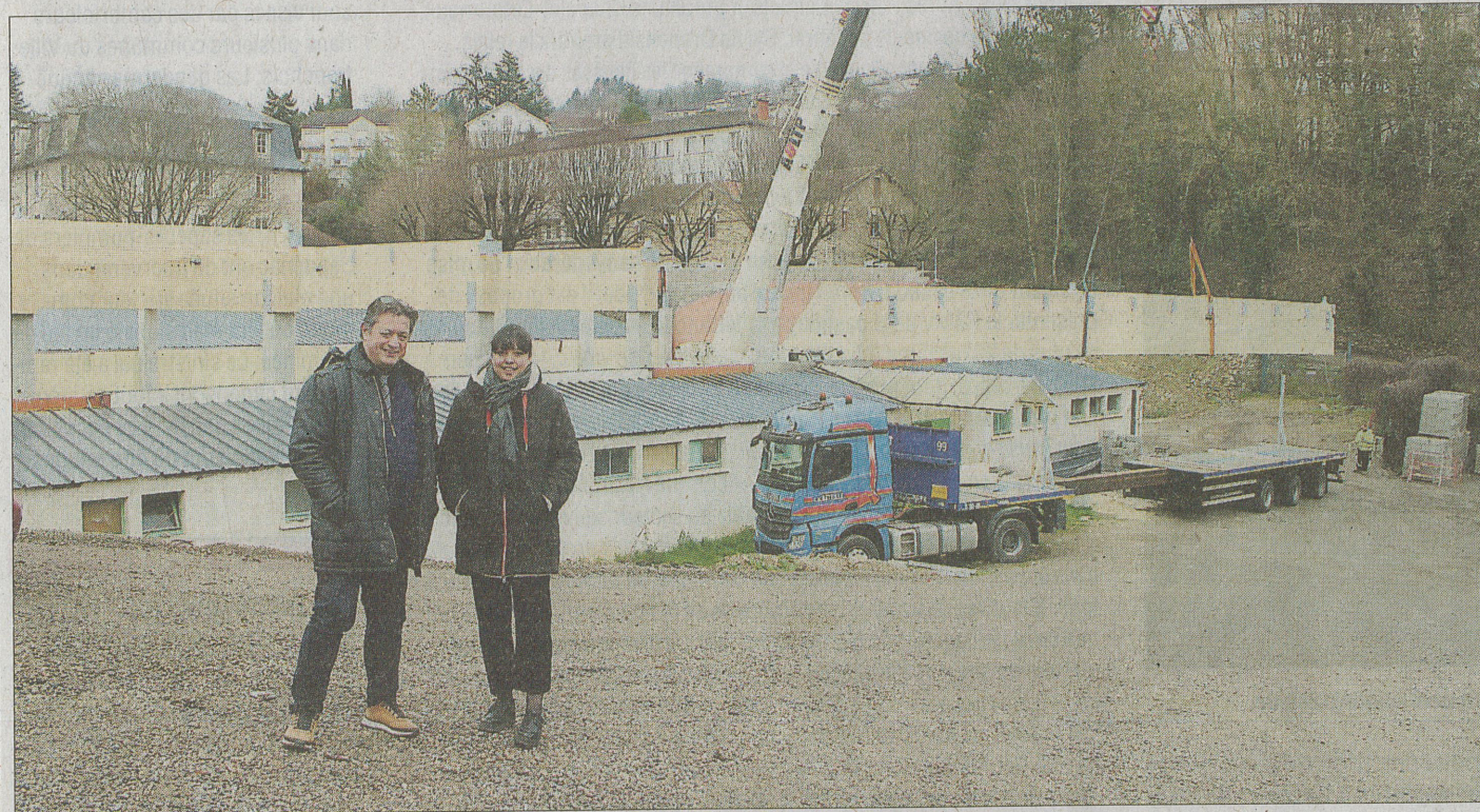
Christophe Reynaud, le directeur de Saint-Joseph et Fanny Grès, l'architecte sur le chantier de ce projet à 2 millions d'euros. \E.L.
